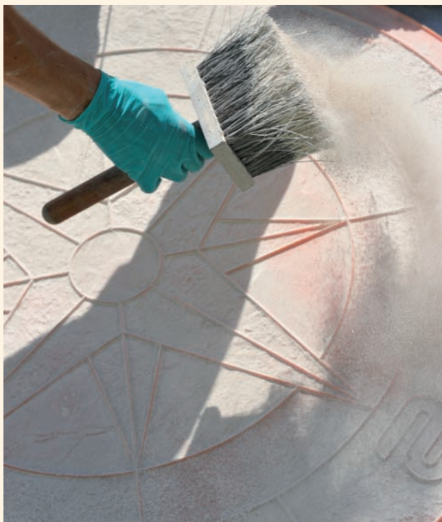
Nécessitant un savoir-faire technique pointu, facile à acquérir grâce aux stages de formation proposés par Unibéton en partenariat avec Moderne Méthode, le béton empreinte requiert rigueur et minutie à chaque étape de la mise en œuvre. L'application des agents de démoulage, ci-dessus, demande une gestuelle précise et maîtrisée.
